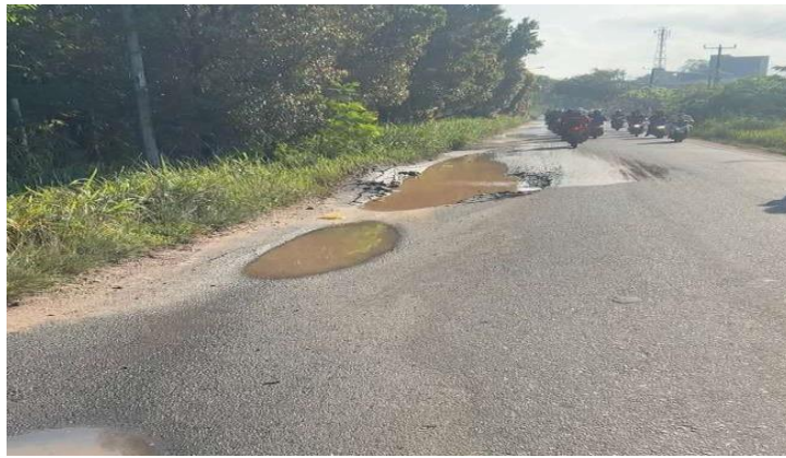
Gambar 2. Lokasi jalan Lintas Bagan pada tahun 2023
