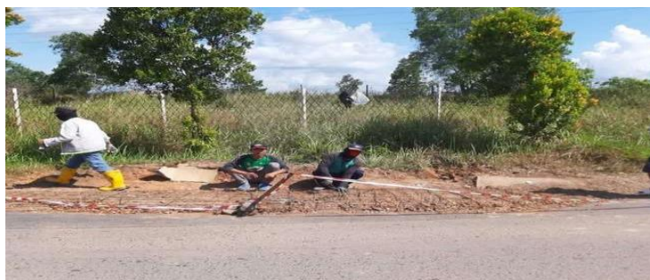
Gambar 3. Perbaikan jalan oleh warga Piayu Residence
